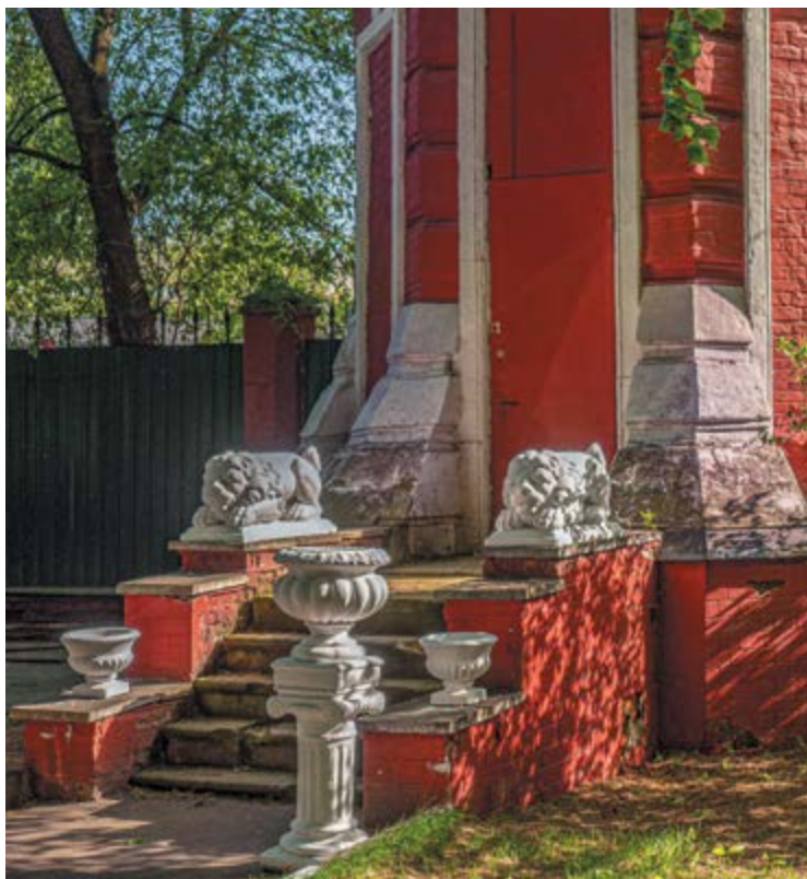
■ Контрфорсы в нижней части башни центральных ворот (скульптуры и вазоны – XXI века)
