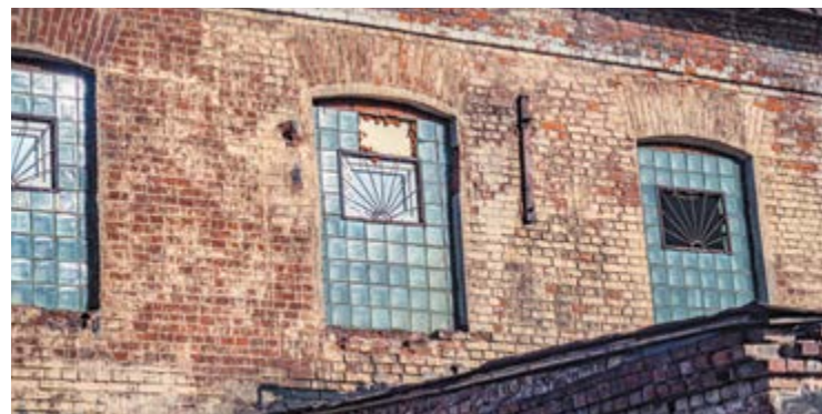
■ Сушильный корпус (фрагмент фасада)
