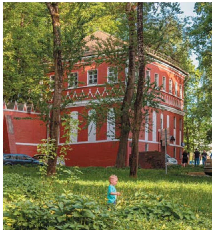
■ Юго-западный служебный корпус
