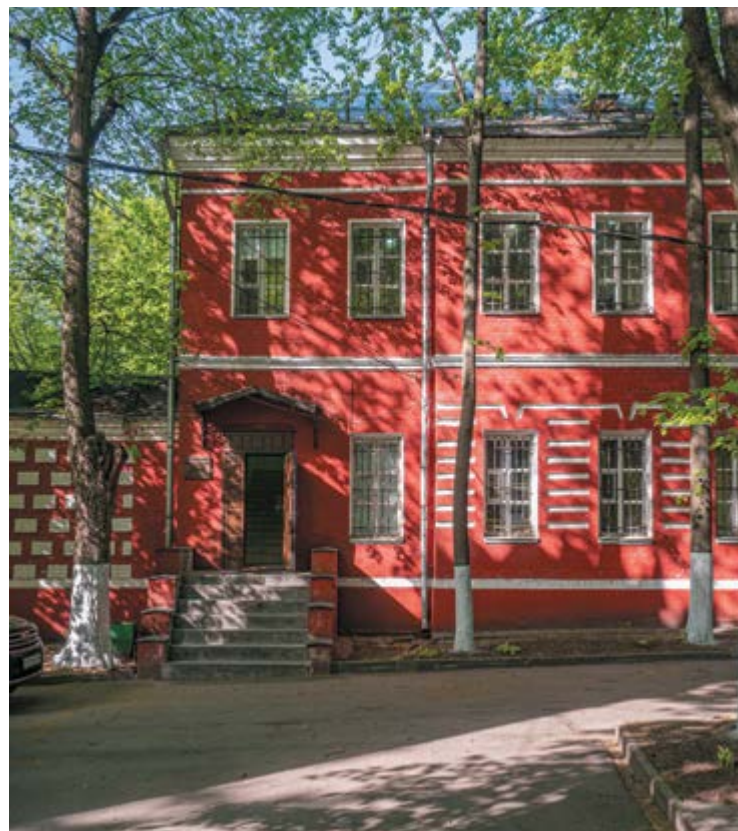
■ Северо-западный боковой флигель
