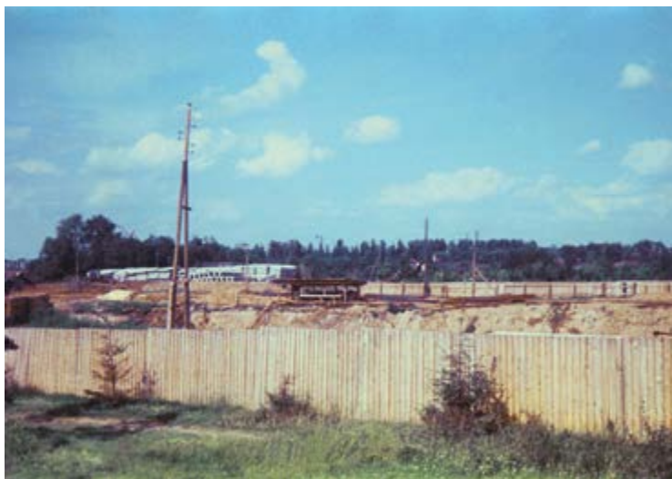
■ Начало строительства станции в 1963 году. Автор фото Виктор Петров
