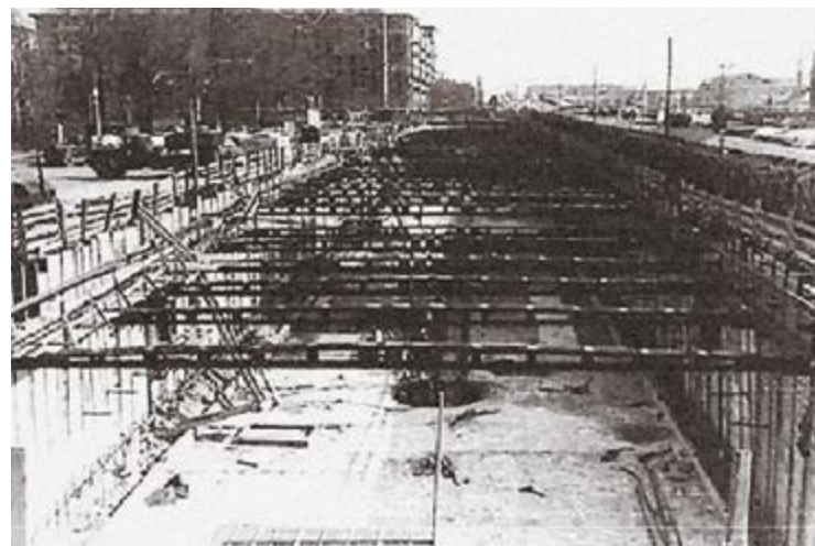
■ Строительство станции метро «Войковская»
